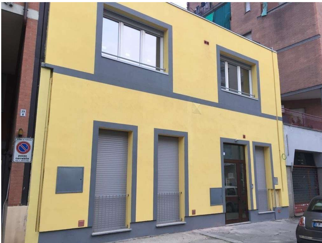
Foto Facciata “CASAVINCENZO” di Via Scarlatti, 41 a Torino (Circ.VI)
